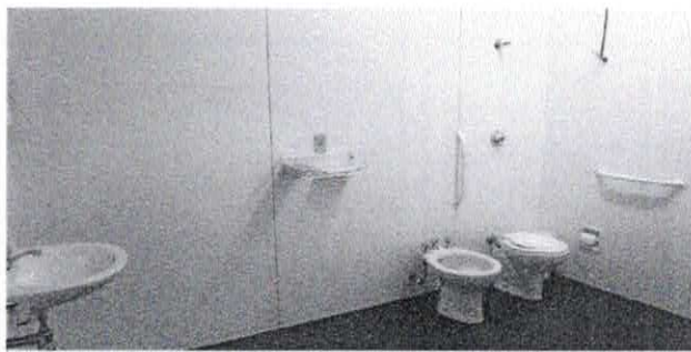
SANITÁRIOS NO LABORATÓRIO
