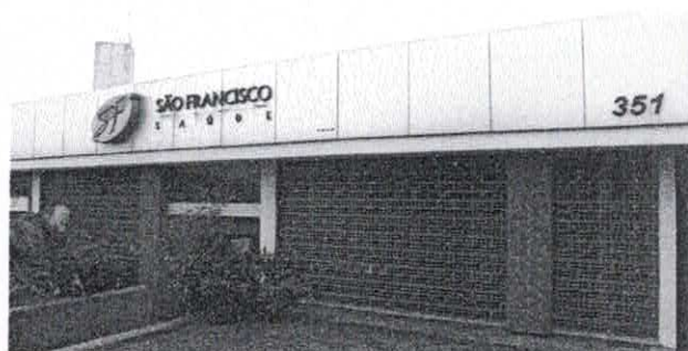
VISTA DA FACHADA DO ACESSO AO LABORATÓRIO - SETOR 04
