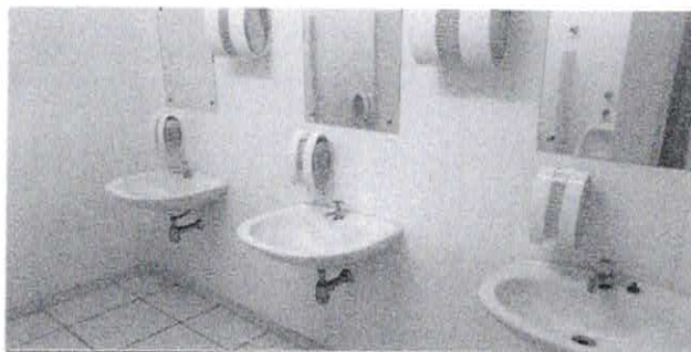
SANITÁRIOS - LABORATÓRIO - SETOR 04
