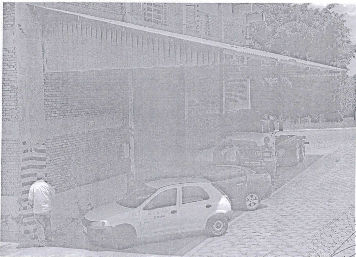
VISTA DO PORTÃO INTERIOR - FRENTE
